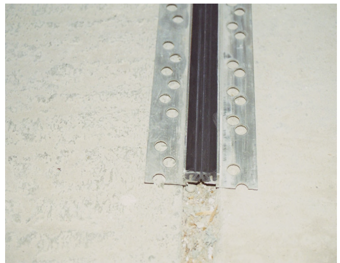
Photo: Bewegungsfuge, hier noch über nicht eingebaut, vorgesehen für Verbundestrich
