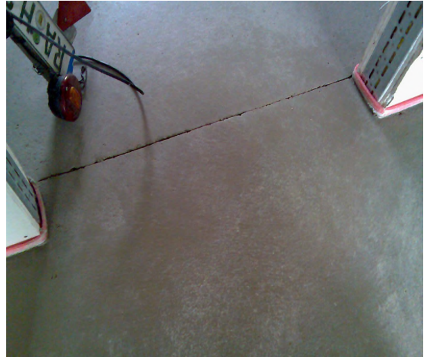
Photo: Scheinfuge im Türbereich
